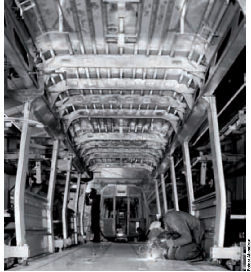
Für die Pariser Metro: Wagenkasten mit zusammenschweißten Großprofilen
